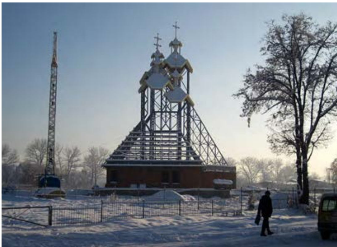
Рисунок 4.4 - Вигляд на каркас Церкви по вул. Ленкавського м. Івано-Франківськ, архітектор Боднар О. Я.
